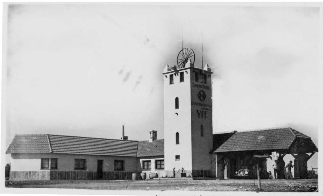
Hostería y Estación de Servicio “San Antonio”, conocida como “La Rueda”. Década de 1930.
